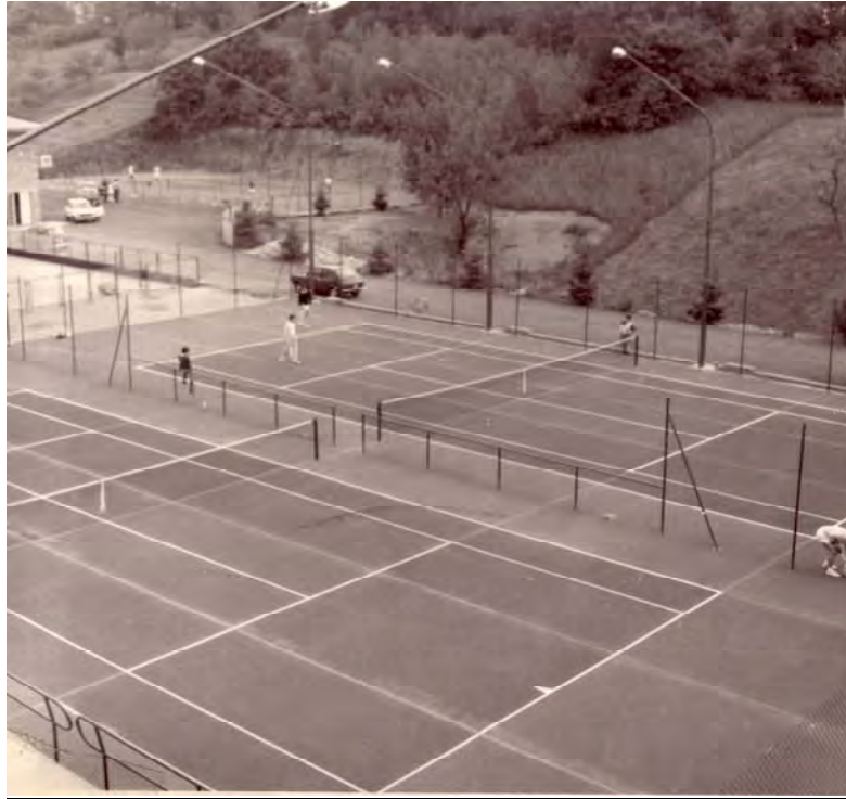
Vista sui nuovi campi da tennis
